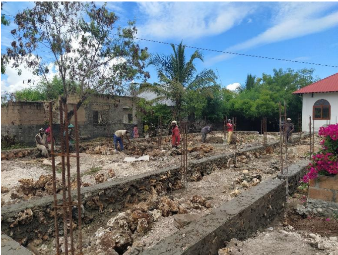
Dit voorjaar legden we reeds de fundamente van MILAT IBRAHIM NURSERY SCHOOL (Jambiani)
