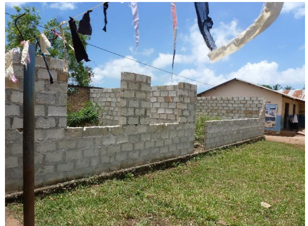
De bouw van drie nieuwe klaslokalen in de secundaire school van MUUNGONI werd opgestart
