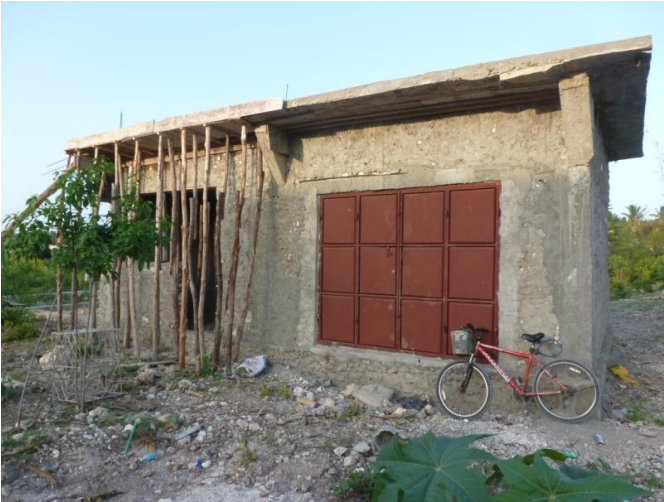
Het medisch centrum in aanbouw
